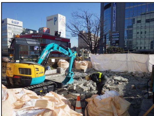
ブロック3の施工状況
