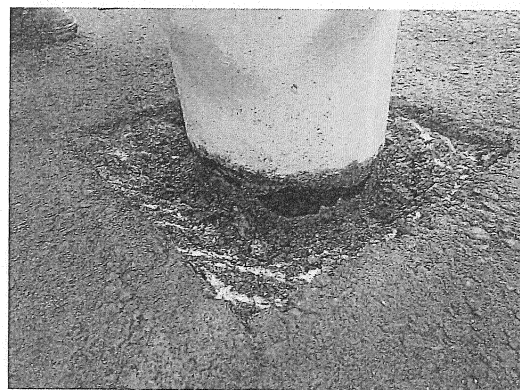
【基礎部が腐食した道路照明灯の現況写真】
