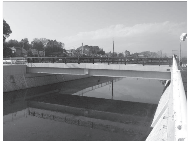
【大山橋（引地川）架替完成】
