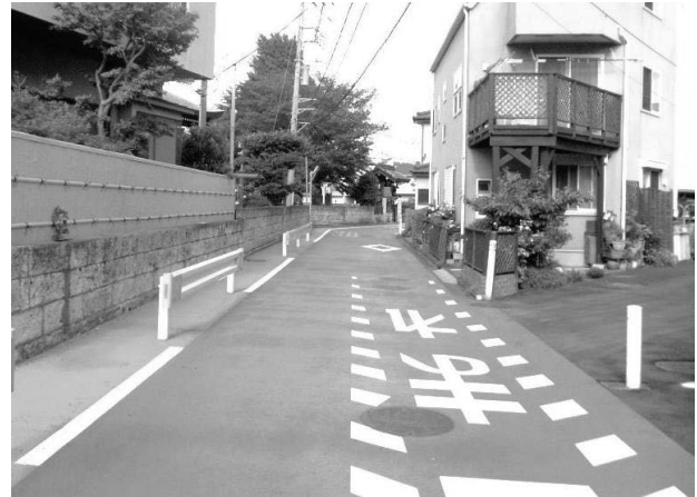
北仲通り線【整備後】 (遮熱性舗装 (カラー舗装))
