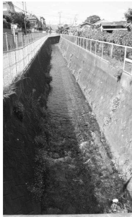
〔滝川・補修後〕
