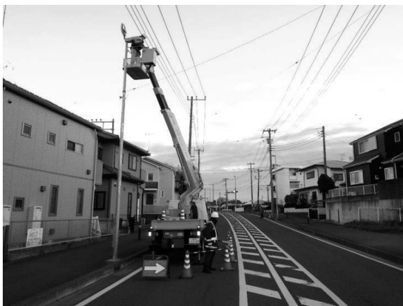
道路照明灯点検状況
