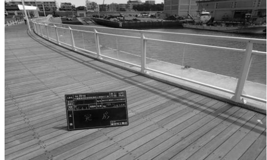
西防波堤転落防止柵復旧完了 (中央部)
