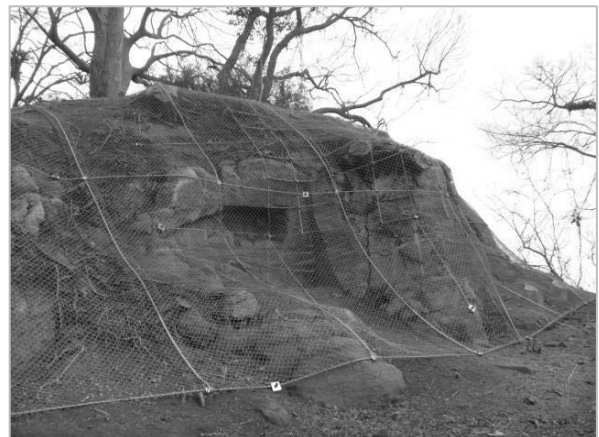
法面对策工事 (御所ヶ谷公園)
