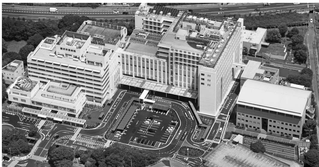
再整備完成後全景
