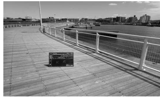
西防波堤転落防止柵復旧完了 (先端部)
