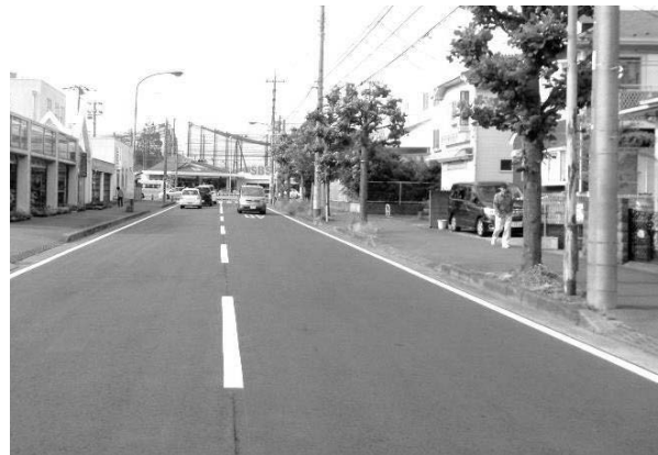
善行長後線【整備後】
