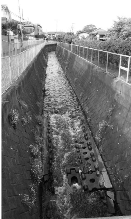
〔滝川・補修前〕
