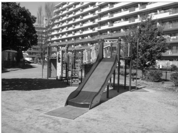
遊具改修工事 (第二花立公園)
