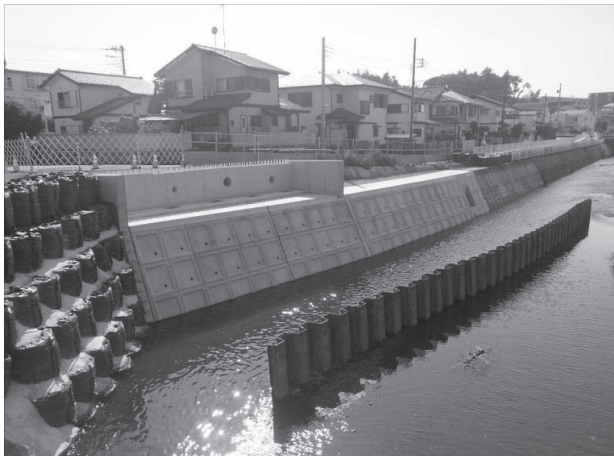
【蓼中橋（蓼川）右岸側橋台、護岸完成】
