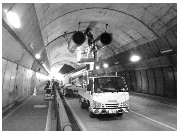
ジェットファン撤去状況（大庭トンネル）
