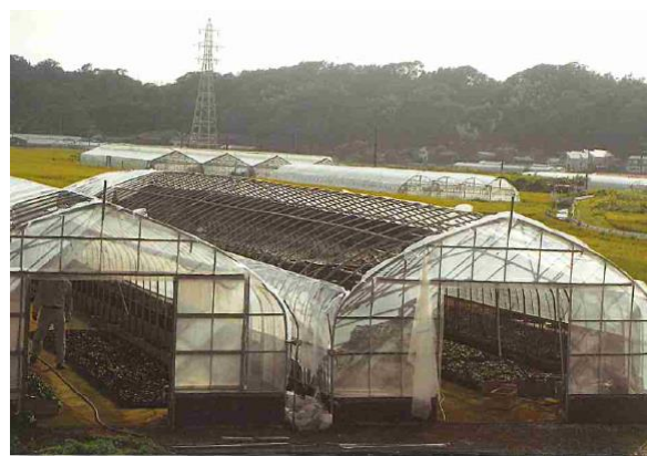
ビニールハウス損傷状況
