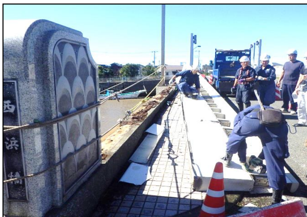
【西浜橋損傷状況】
