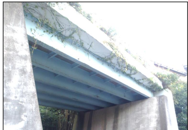
【竜昇橋現況写真】
