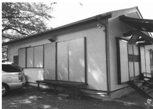
令和元年度に修繕を行った遊行通二丁目自治会館（藤沢東部地区）
