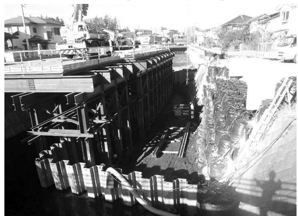
蓼中橋【左岸護岸築造】
