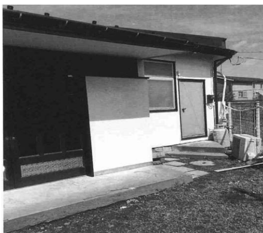
令和元年度に修繕を行った丸山自治会館（湘南大庭地区）
