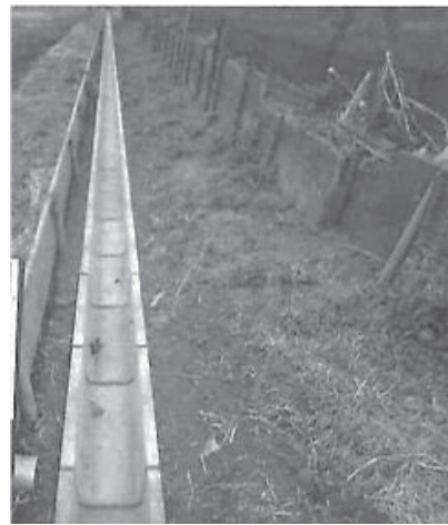
(用水路改修後)
