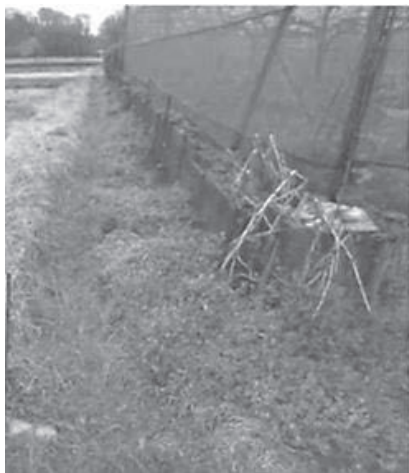
(用水路改修前)
