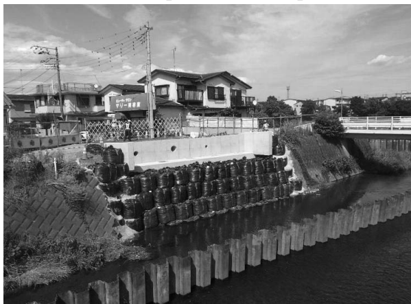
蓼中橋【左岸橋台完成】
