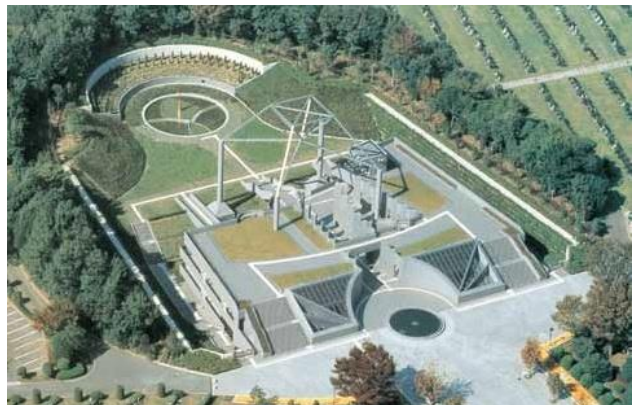
【立体墓地建物 外観】
