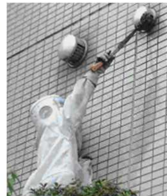
【スズメバチの巣の撤去風景】
