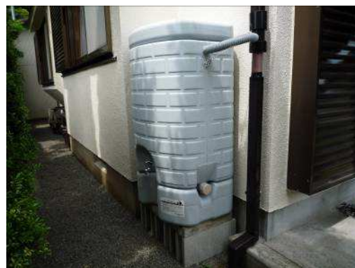
【雨水貯留槽設置例】
