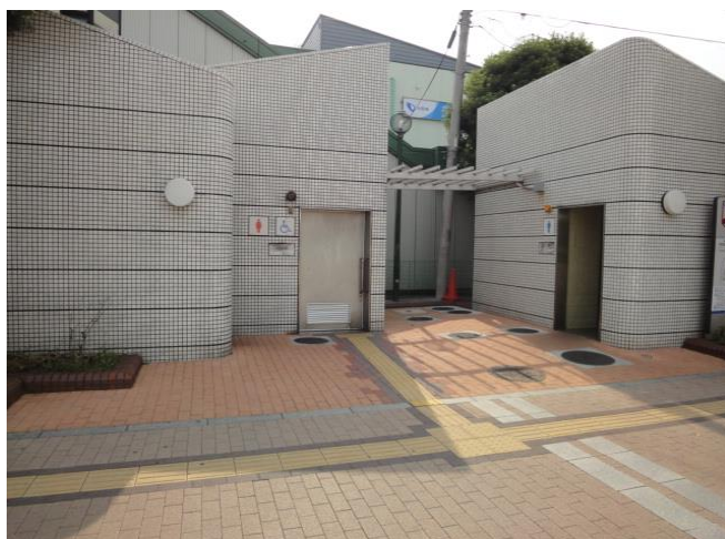
【公衆便所外観】
