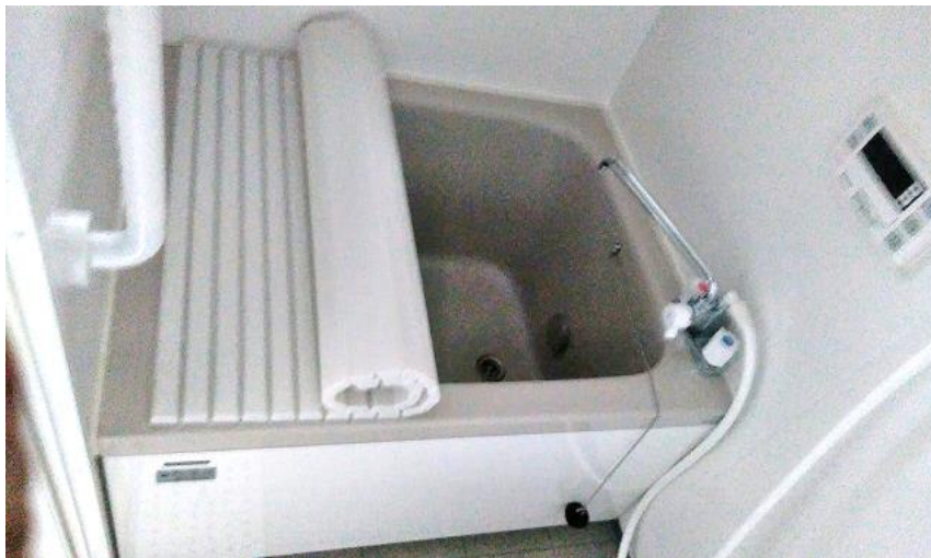
【浴室ユニット化工事 施工事例】
