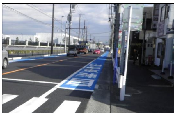
整備事例（県道30号戸塚茅ヶ崎）
