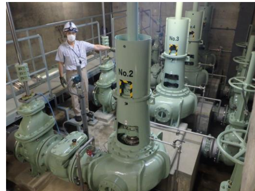
污水ポンプ改築後
