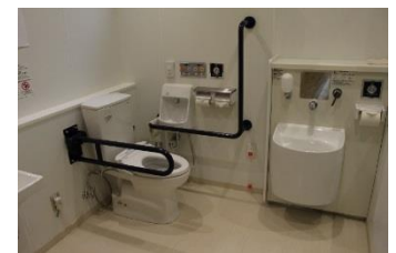
多目的トイレ
