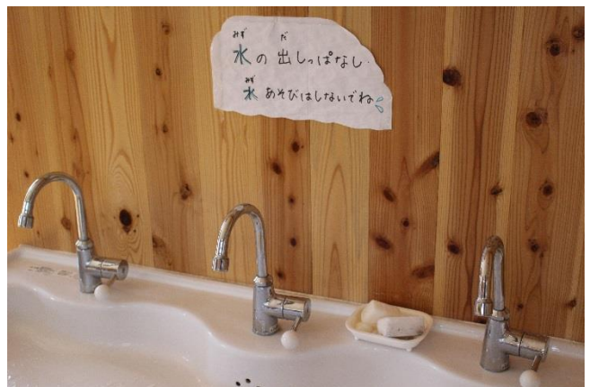
施設利用者への節水の呼掛け
