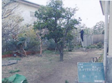
専門業者による樹木修繕
