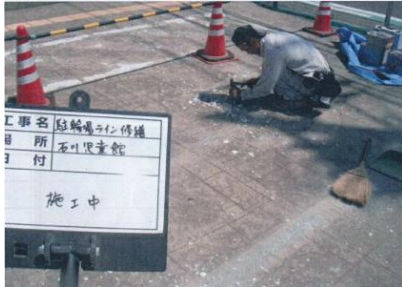
専門業者による施設修繕
