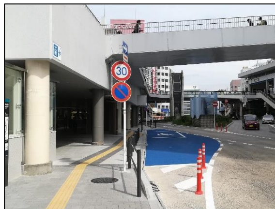
北口交通広場整備後
