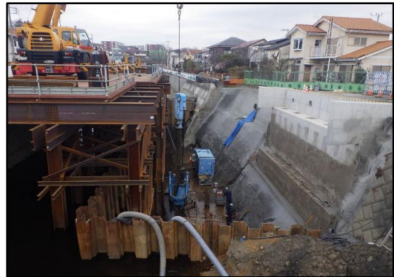
橋台・護岸築造状況
