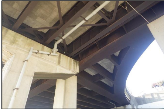
大庭大橋（引地川）縦桁改修
