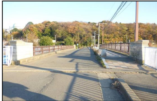
天神橋（引地川）橋面改修
