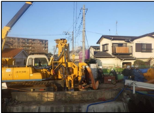
橋台基礎築造作業
