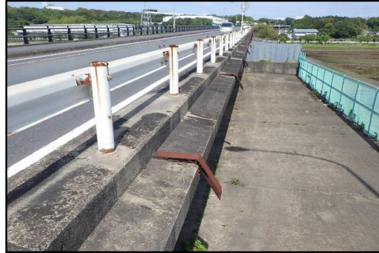
大庭大橋（引地川）高欄地覆改修
