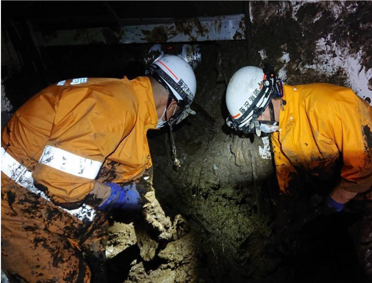
建物内の土砂排除
