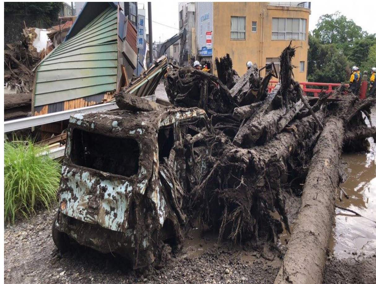
活動現場付近の被災状況
