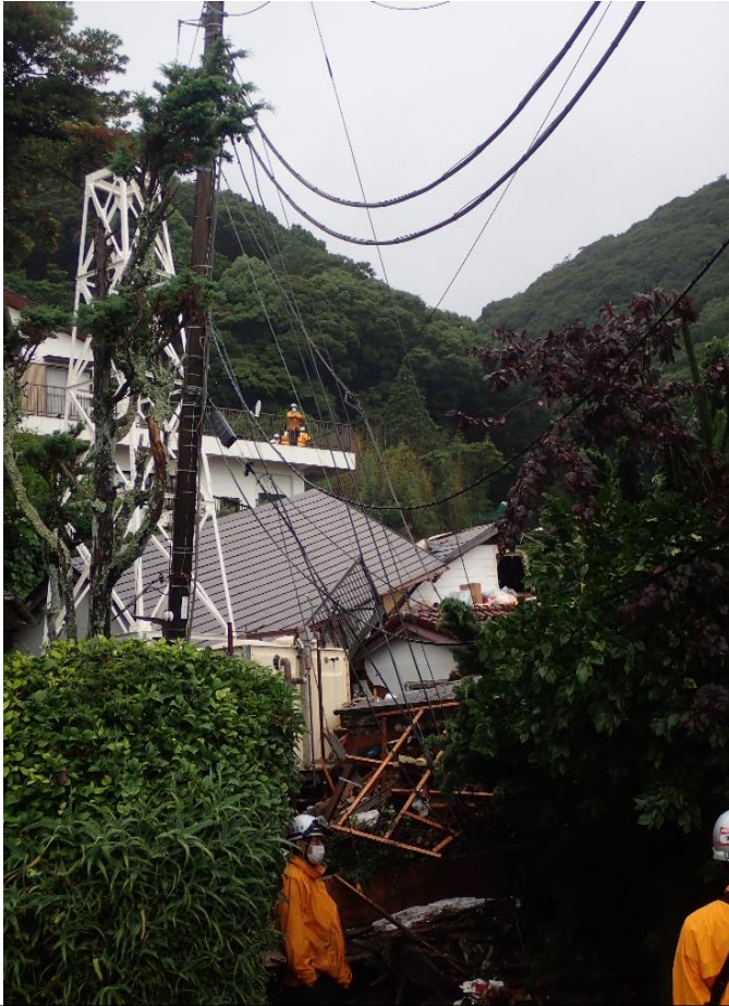
高台からの安全管理状況
