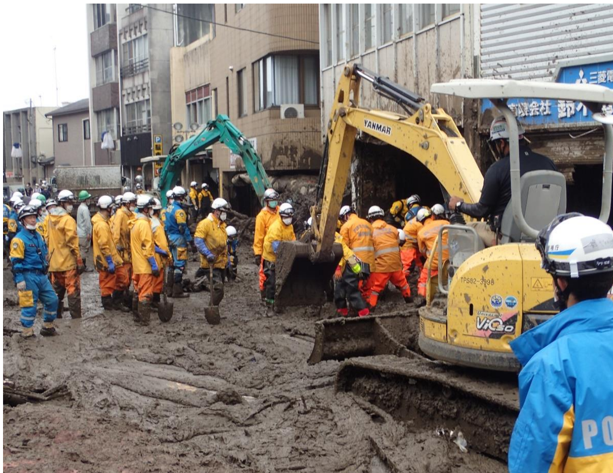
被災建物内の土砂排除 重機との連携
