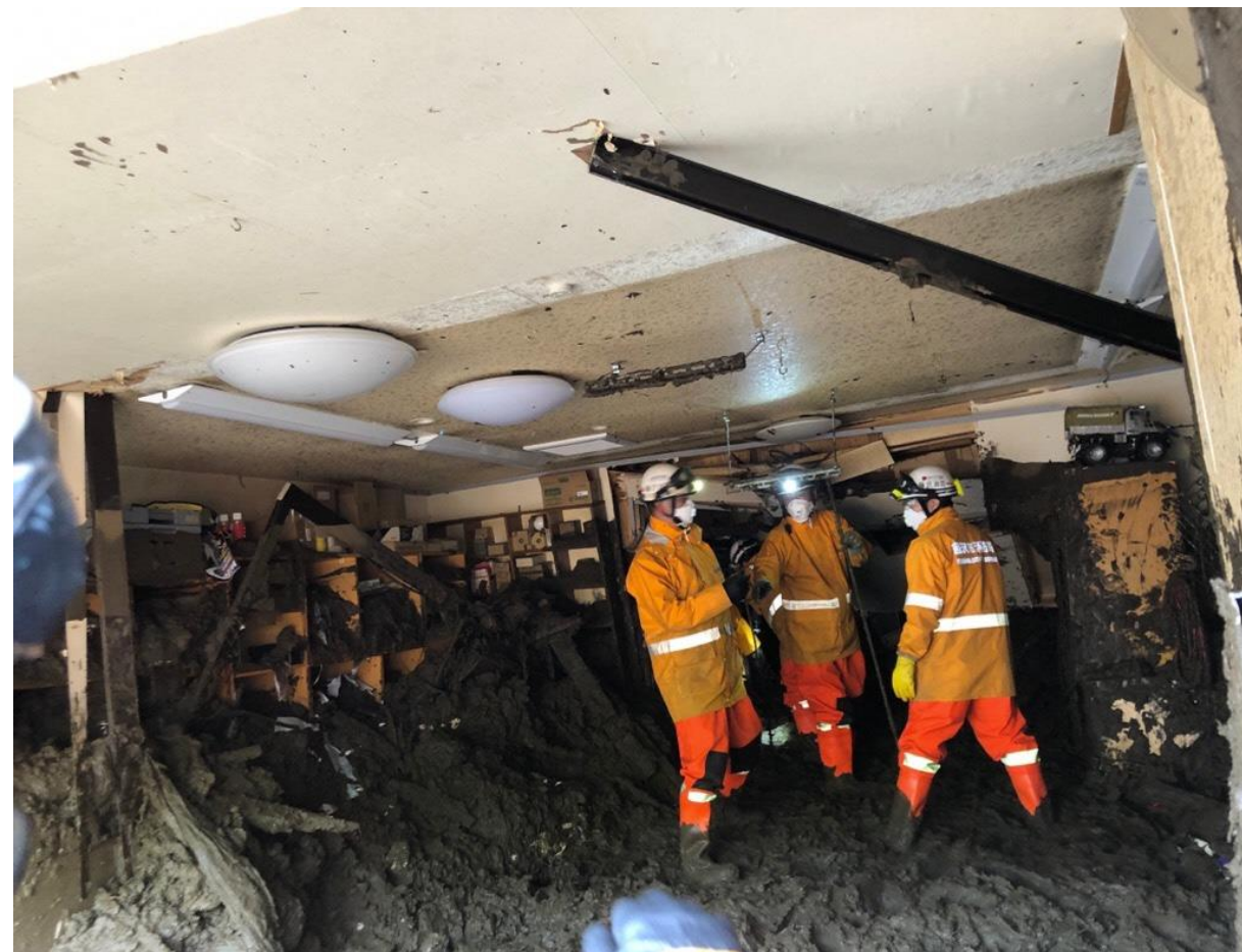
被災建物内の土砂排除
