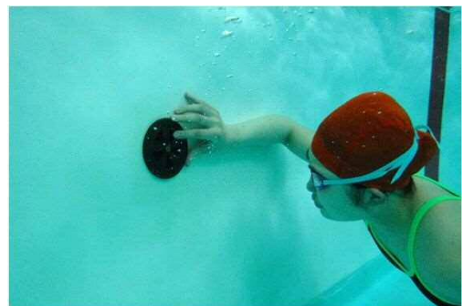
プールでは毎日排水口の目視・触手点検を実施
