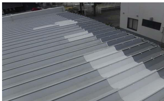
2020年2月塗装修繕後
