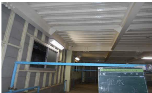
2020年3月 塗装修繕後
