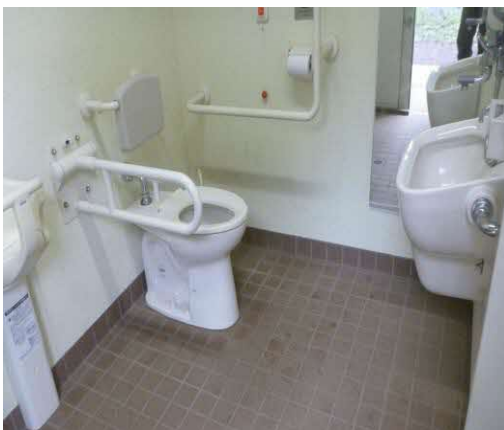
多目的トイレの設置
