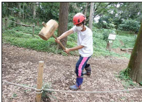
職員による軽微修繕
