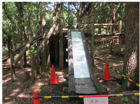
（修理中のアスレチック遊具）
