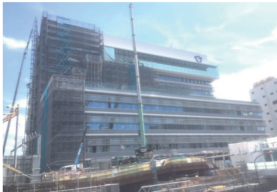
<完成間近な新庁舎>
