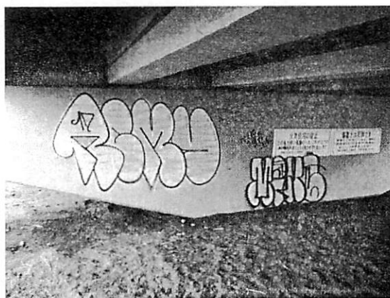
江の島大橋の橋脚
