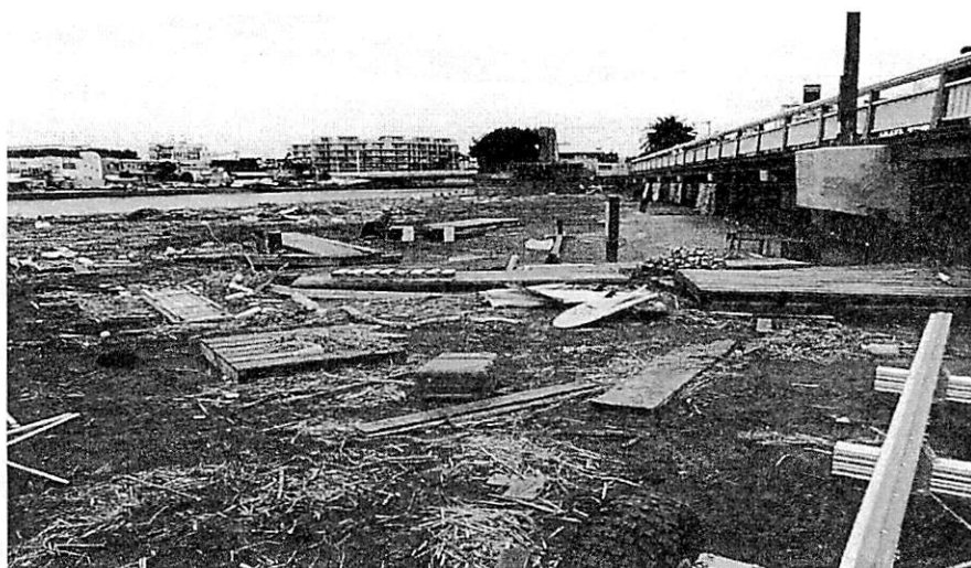
片瀬東浜 江の島大橋付近（2017年10月台風21号による被害）
