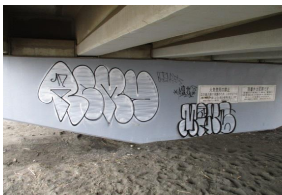
江の島大橋の橋脚
